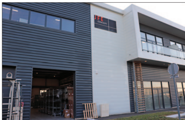
Dans ce bâtiment de 1 300 m 2 , acheté "dans l'urgence" à Servon en novembre 2020, six opérateurs fabriquent des garde-corps, pare-vue, coulissants et fenêtres à frappe.
